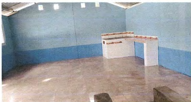
Foto1: Piso cerámico instalado
