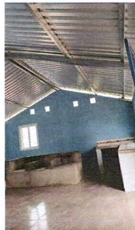
Foto 2: Banco de trabajo, estructura de techo pórtico, lámina troquelada calibre 26 instalada.
