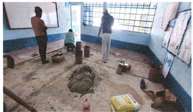
Foto 2: Avance de la instalación del piso cerámico.
