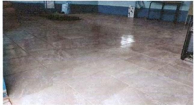
Foto 4: Instalación finalizada del piso cerámico.
