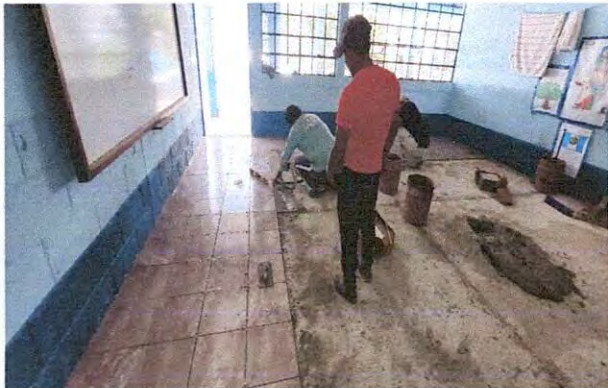
Foto 3: Vista general y avance la intalación del piso cerámico.
