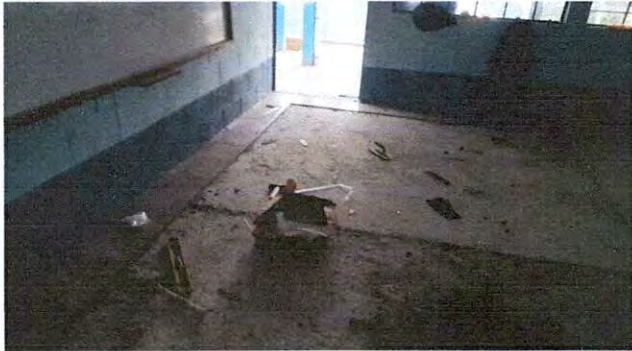
Foto1: Inicio a la instalación de piso cerámico en el módulo de aula 3.
